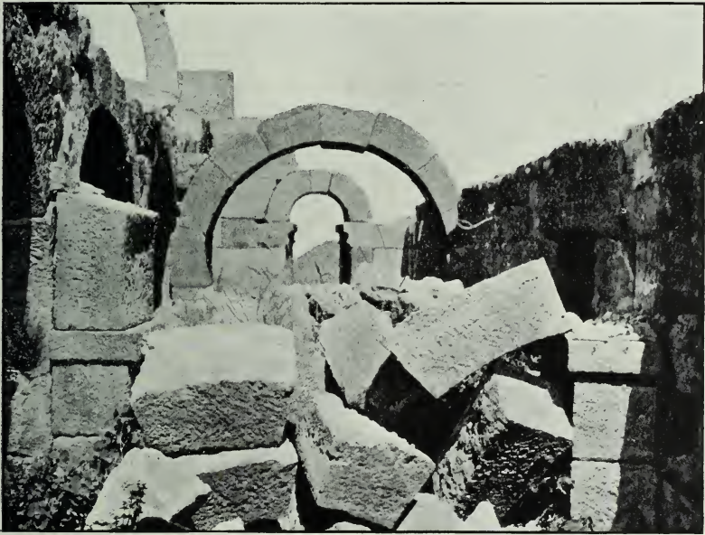
FIG. 123.—No. 31, S. aisle, looking E.
